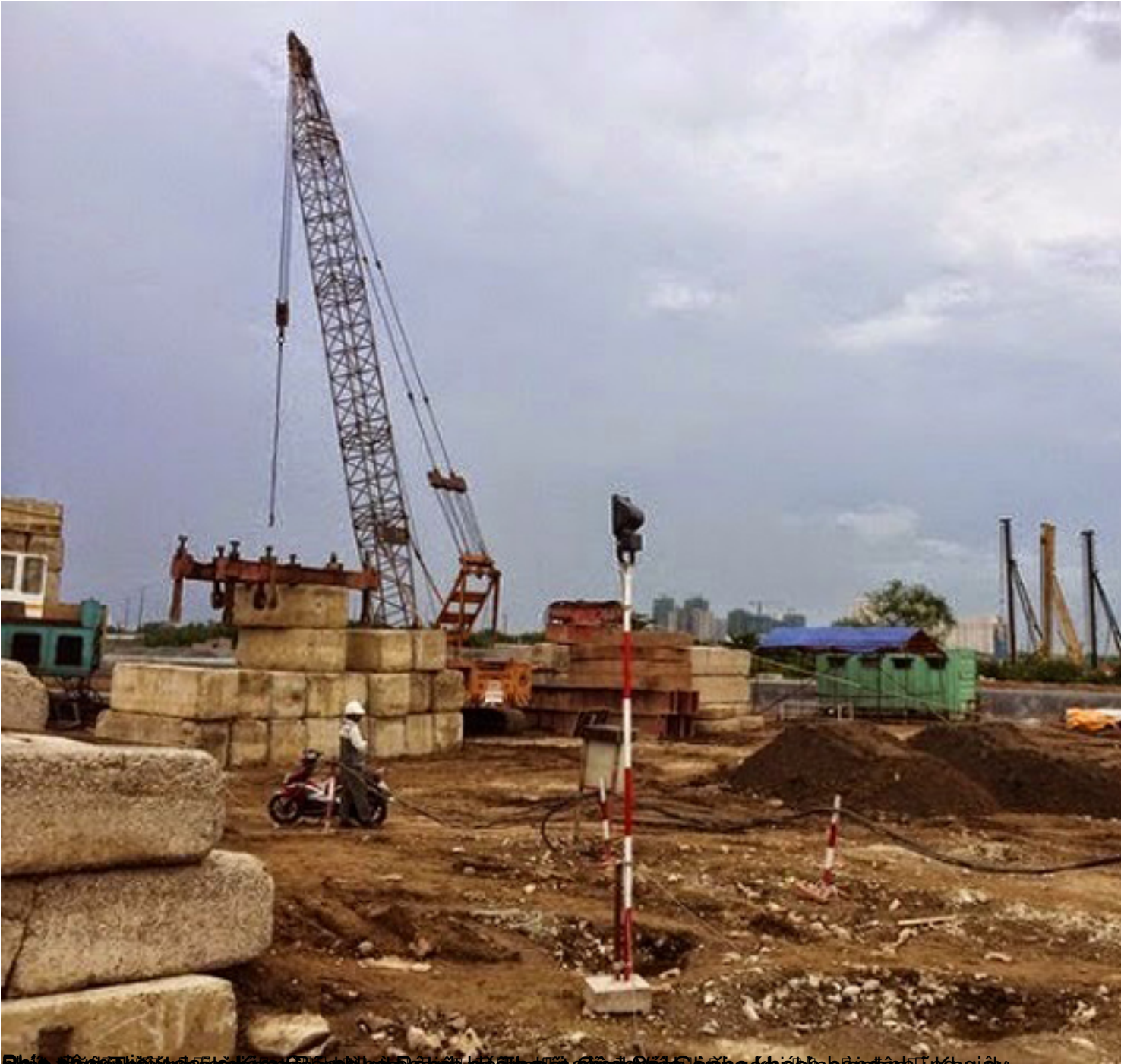
Phía tây của hầm đã được thi công và các công nhân đang làm việc tại sân bãi, công nhân đang vận chuyển vật tư xây dựng.
